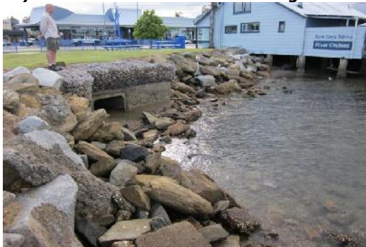
g) Stormwater outlet
