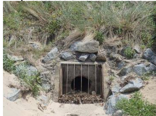
h) Stormwater outlet
