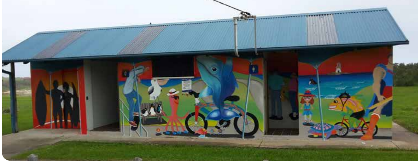
Dalmeny public toilets
